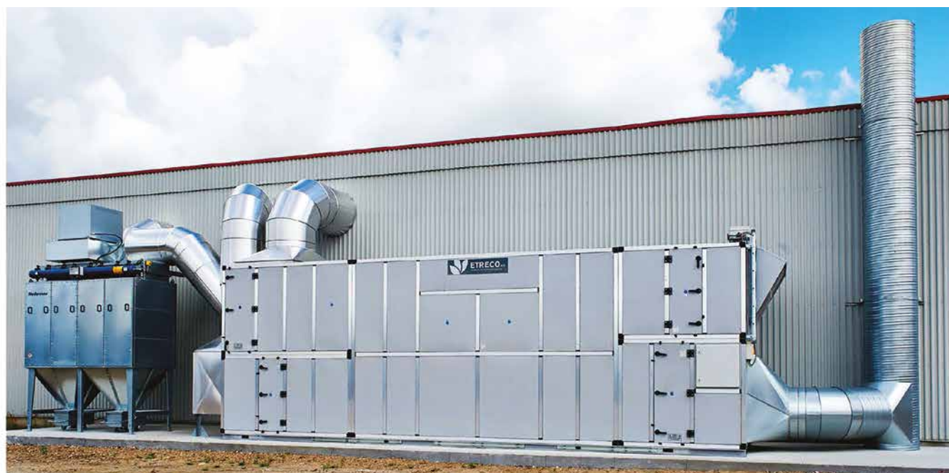
Eksempel på aggregat med varmegenvinding og filter
