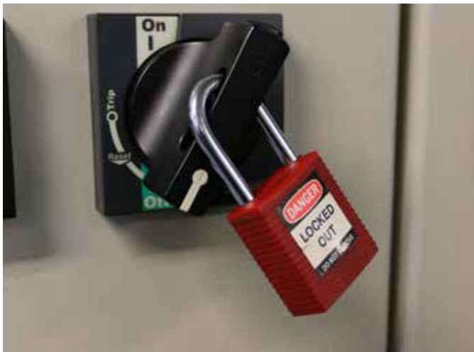
Her eksempler med aflåst forsyningsafbryder.
