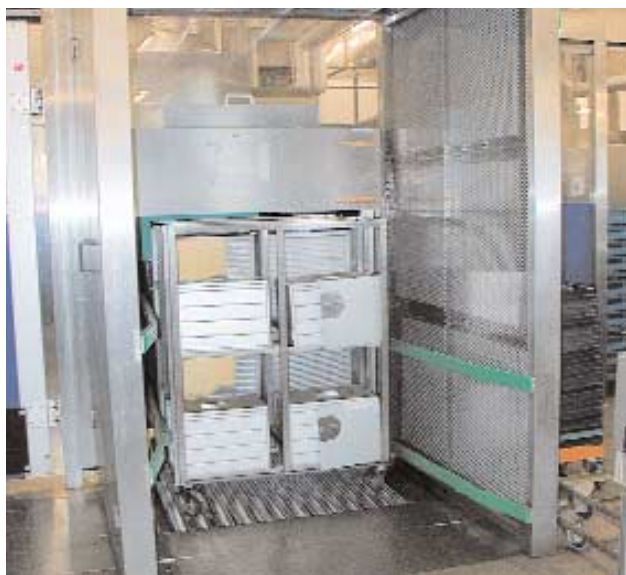
Lydsluse foran åbning ind til stor opvaskemaskine.
