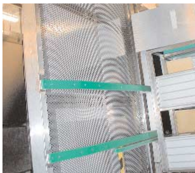
Indervæg i lydsluse ind til stor opvaskemaskine.
