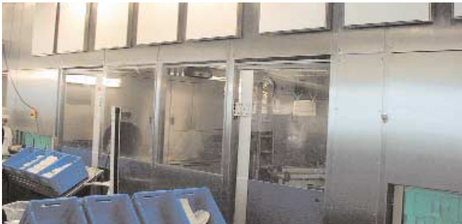
Væg der indkapsler opvaskemaskiner.
