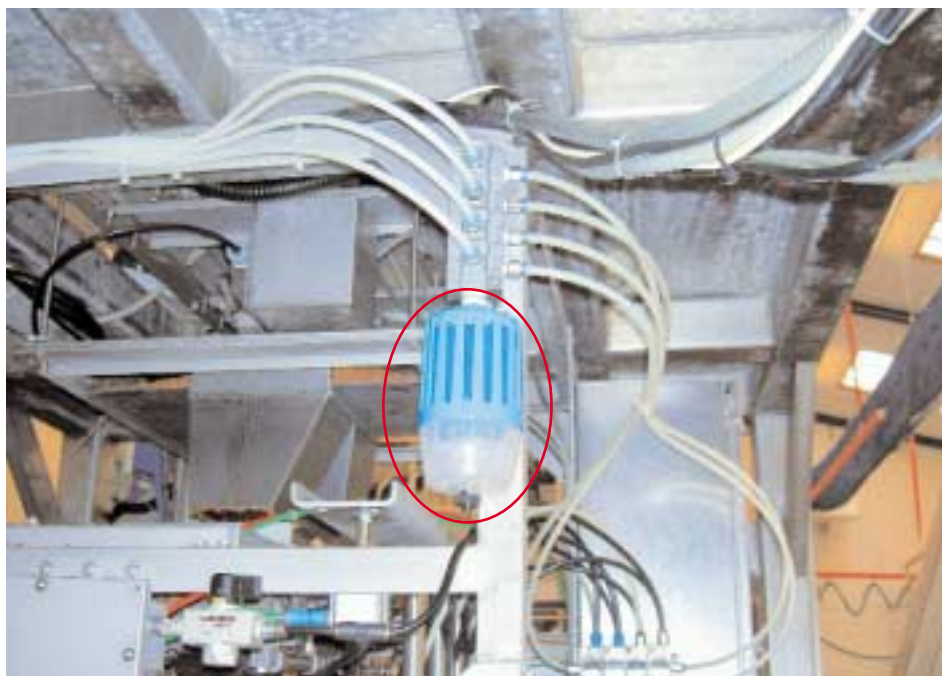
Lyddæmper til udblæsninger fra 8 ventiler.
