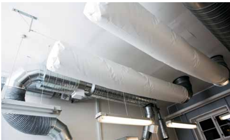
Poseindblæsning af plasttypen med hullerne pegende opad.
